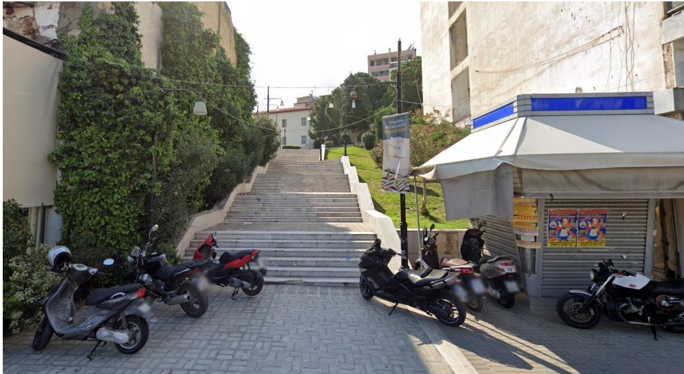
Εικόνα 7 : Σκάλες σύνδεσης της πλατείας Ελευθερίας με την πλατεία Κοντόπουλου (φωτ.Β)
