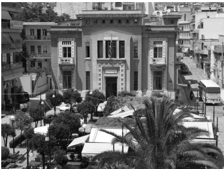
Εικόνα 15 : Διατηρητέο κτήριο Νομαρχίας Φθιώτιδας (ΦΕΚ 132/Β/8.3.1991)
