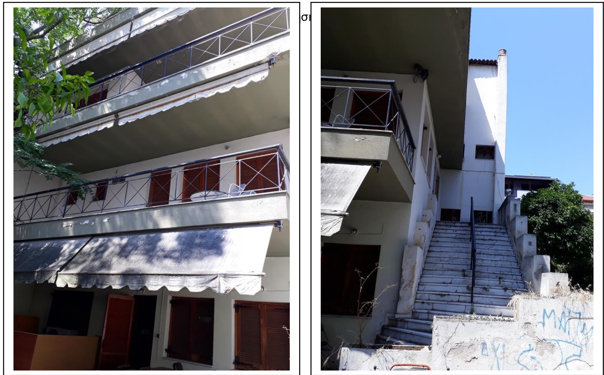
Εικόνες 4,5: πίσω όψεις κτιρίου
