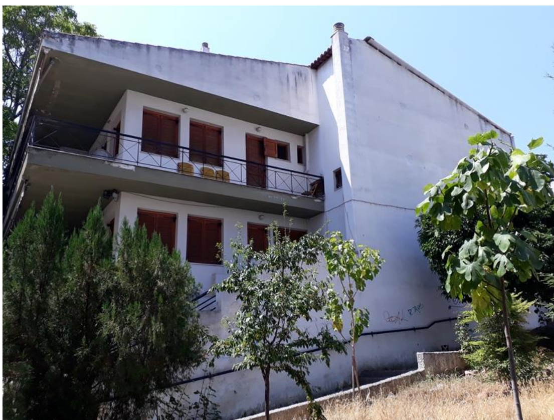
Εικόνα 3: Πλαϊνή όψη του κτιρίου
