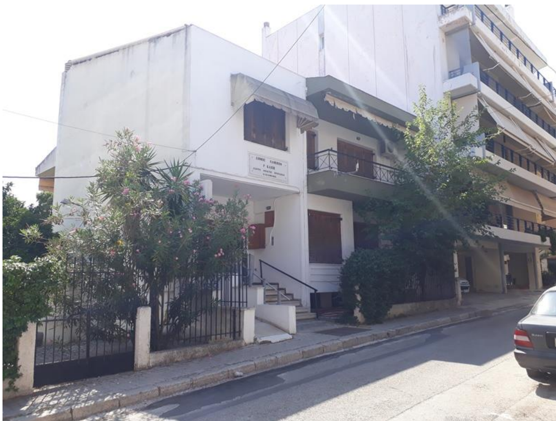
Εικόνα 2: Όψη του κτιρίου από την οδό Μακροπούλου – είσοδος στο κτίριο
