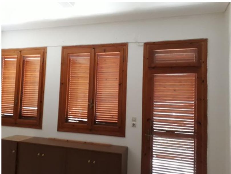
Εικόνα 6: Ανοιγόμενα ξύλινα κουφώματα με μονό υαλοπίνακα
