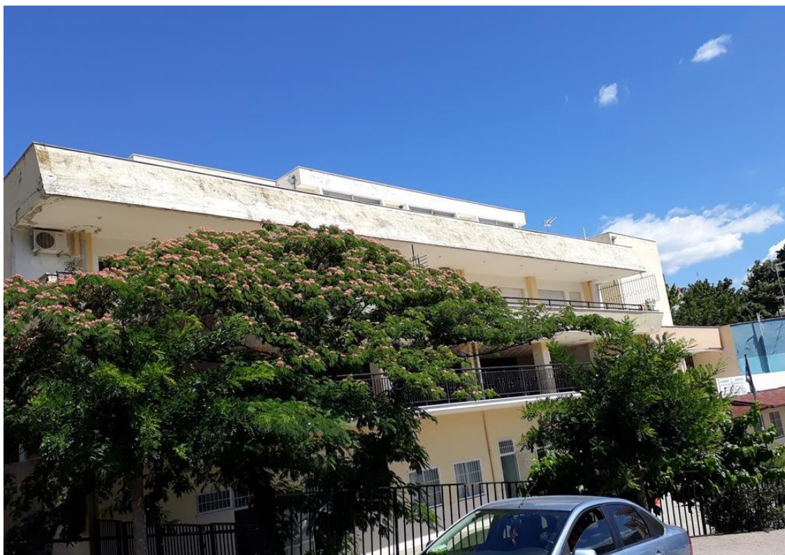
Εικόνα 4: Νοτιοανατολική πλευρά κτιρίου (οδός Κάλβου)
