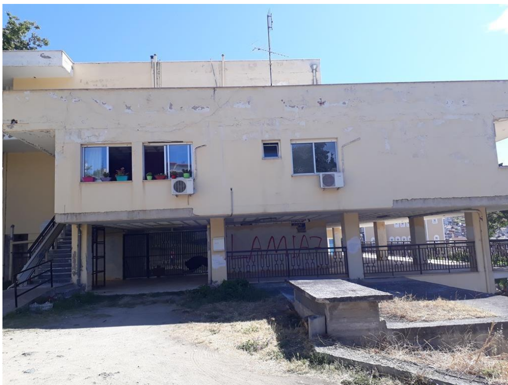
Εικόνα 2: Νοτιοδυτική πλευρά κτιρίου (οδός Κάλβου)
