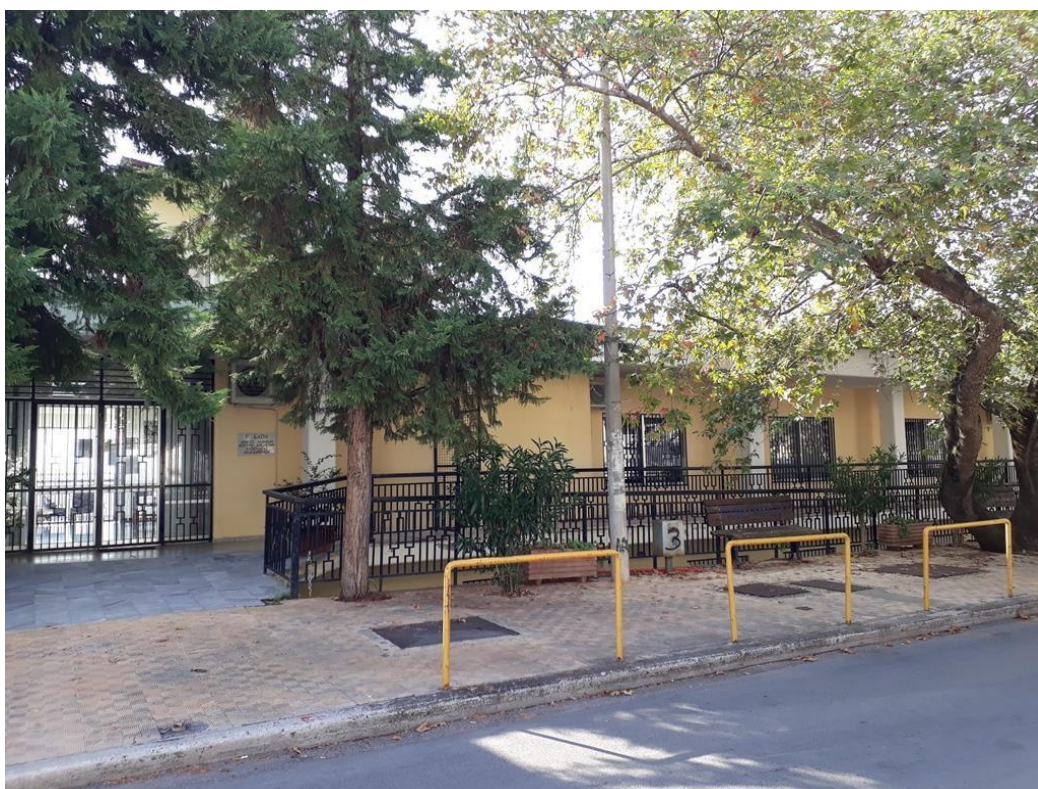
Εικόνα 3: Βορειοδυτική πλευρά κτιρίου (οδός Τυμφρηστού)
